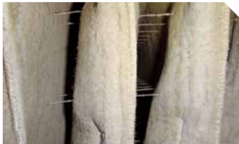
Рис. 1 Требуется регулярно осматривать и заменять воздушные фильтры
