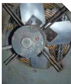
Рис. 1 Чистые лопасти, центральное положение и оптимальная высота вентилятора
