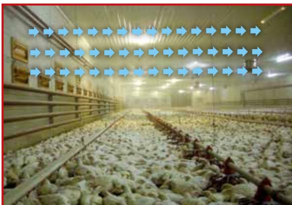
Дым движется вдоль потолка, затем опускается вниз по противоположной стене птичника.
